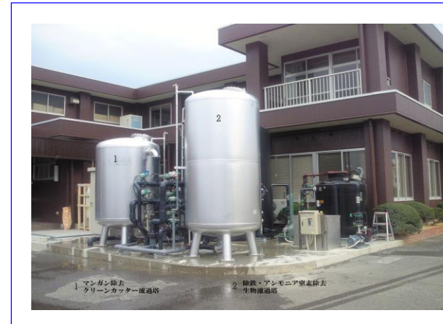
図-3. ミネラル水工場の生物ろ過システム
