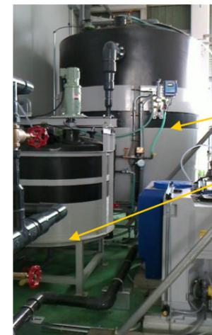
写真-②凝集攪拌槽・処理水槽兼逆洗水槽
