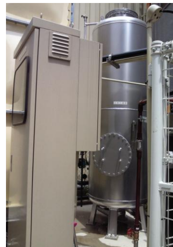
写真-5. 豊中市のNH 4 -N除去・生物処理施設
