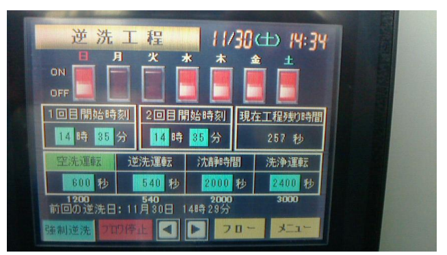
写真-4. 高濃度 Mn 除去システムの遠隔監視システム画面
