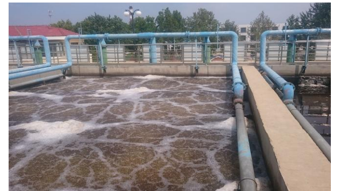
図3. 某市 下水処理場の硝化槽の写真
